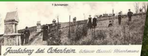
Unterhalb des Pilgerplatzes 1914
